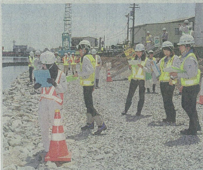
護岸復旧工事現場で「なでしこパトロール」を行う建設会社の女性従業員ら—徳島市応神町古川
