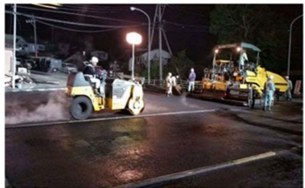
写真-1 交差点復旧状況(国道443号線寺迫交差点応急工事, 平成28年4月18日~20日, (一社)熊本県建設業協会提供)
